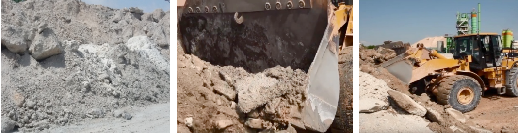
شكل (4) التخلص من مخلفات الخرسانة الطازجة وذلك بوضعها على الأرض حتى تصلدها ومن ثم نقلها إلى المقالب العمومية
